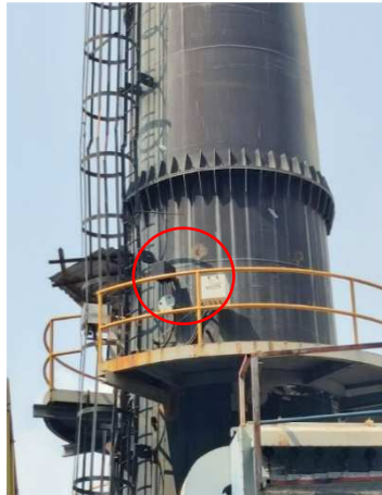
รูปที่ 3-21 ระบบติดตามตรวจสอบฝุ่นอัตโนมัติ (CEMs)
